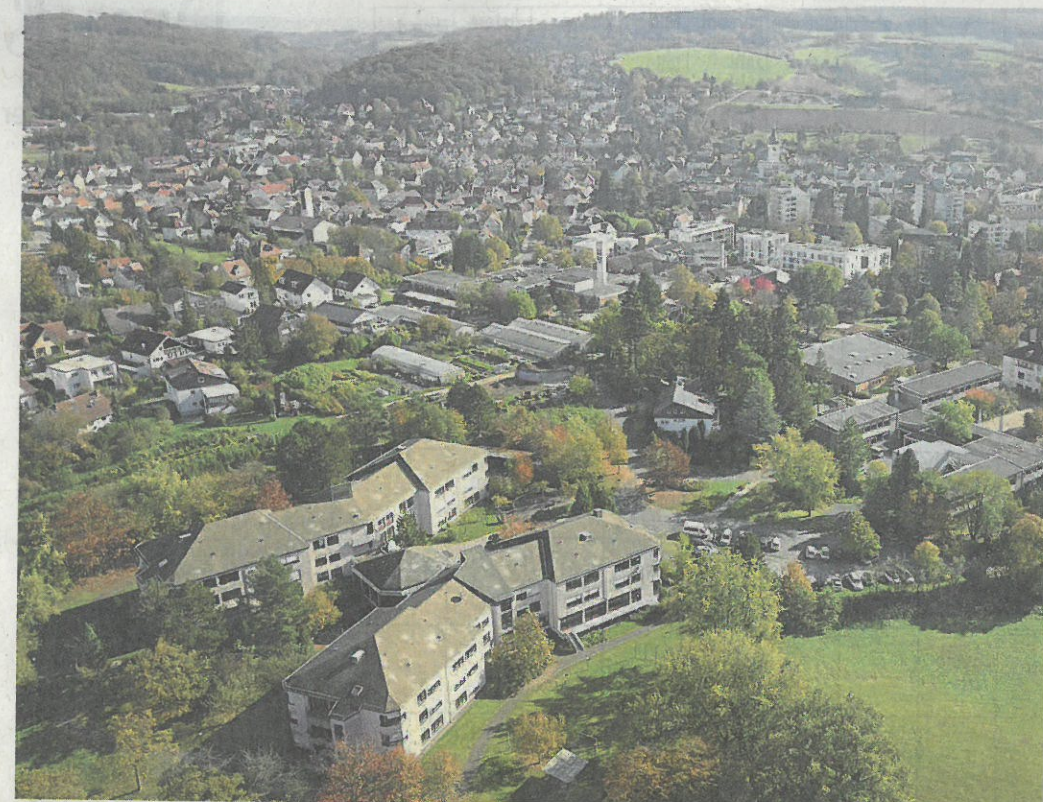
Auf dem Dornberg in Nieder-Ramstadt soll Wohnbebauung entstehen. Die Häuser sind westlich der beiden großen Gebäuderiegel geplant.
